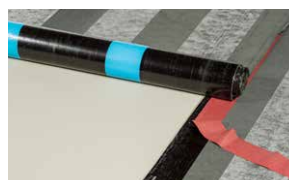
Auf Beton zur teilflächigen Verklebung: Entfernung der unterseitigen Ablösefolie. Zur vollflächigen Verklebung: zusätzlich Vent-Folienstreifen entfernen.
