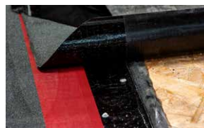
Auf Holzschalung verbleibt die Ablösefolie als Trennlage. Die Naht wird zuerst genagelt und nach Ablösung des Randstreifen verklebt.
