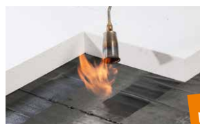
Dämmstoffverklebung durch Einflämmen
