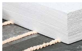
Dämmstoffverklebung mit MOGAT SDF 18
