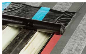
Auf Trapezblech zur vollflächigen Verklebung: Entfernung der unterseitigen Ablösefolie und der Vent-Folienstreifen.
