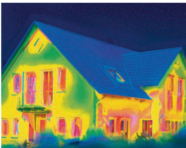
Dieses Dach ist gut gedämmt. Im Gegensatz zu den Wänden
