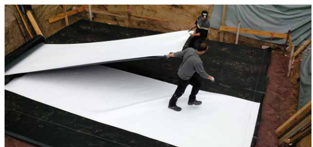
Rissüberbrückende Abdichtung für Bodenplatte und Sockelbereich
