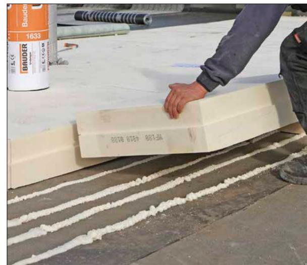
Bei objektspezifischen Besonderheiten kann sich die notwendige Klebermenge erhöhen. Zur Verklebung darf ausschließlich der BauderPIR SKL verwendet werden. Bei geplanter Verwendung von anderen Klebern und bei objektspezifischen Besonderheiten informieren Sie sich bitte bei der Bauder Anwendungstechnik.
